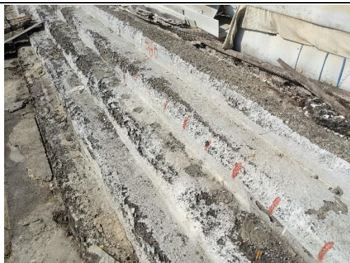
一工區之現況 (拍攝日期 111.1.26)
