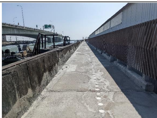
三工區之現況 (拍攝日期 111.1.26)
