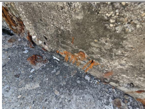
一工區之高壓灌注止漏 (拍攝日期 111.1.26)
