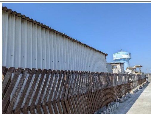
三工區周邊之布袋港漁市 (拍攝日期 111.1.26)
