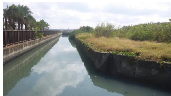
西衛公園旁區域排水
