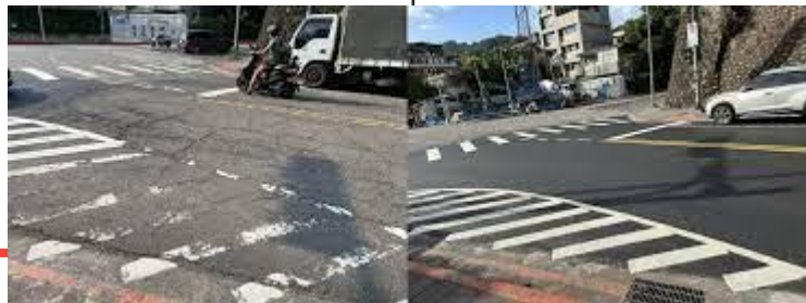
工程減碳新做法(溫拌橡膠瀝青鋪面)
