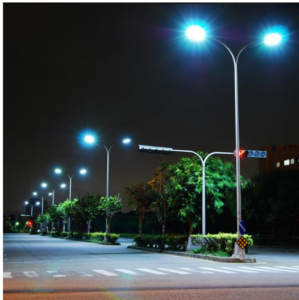
港區公共設施(照明設備)
