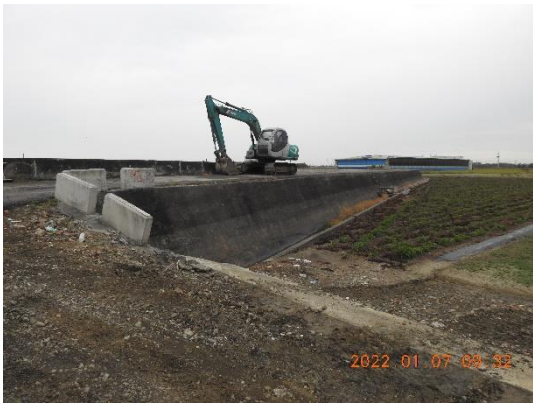
施工現況 ( 拍攝時間 111.01.07 )
