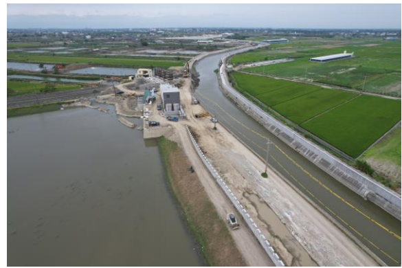
施工現況 ( 拍攝時間 111.04.19 )
