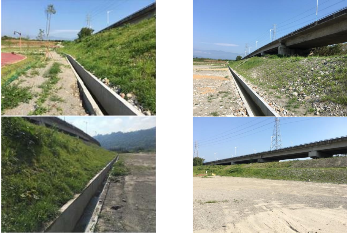
圖 5 南側排水渠道與土坡現況照片
