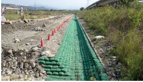
公園南側排水施工中109.01.18
