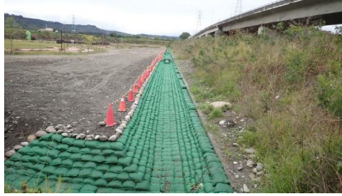
公園南側排水已完工109.02.16
