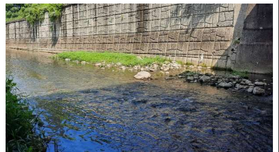
射流溝水岸環境改善工程計畫水域生態工作照，攝於 2021/07/16
