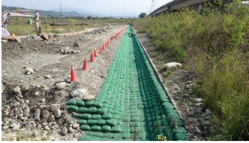
公園南側排水施工中109.01.18
