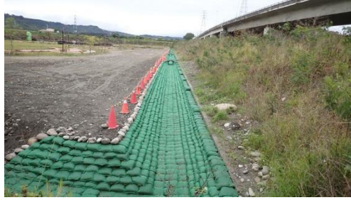
公園南側排水已完工109.02.16
