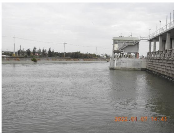
鴨母寮出口閘門外側 ( 拍攝時間 111.01.07 )
