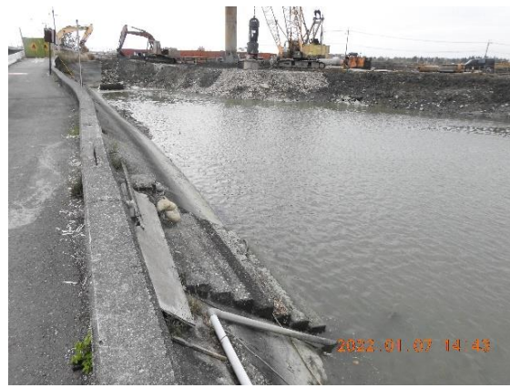
荷苞嶼左岸護坡現況 ( 拍攝時間 111.01.07 )
