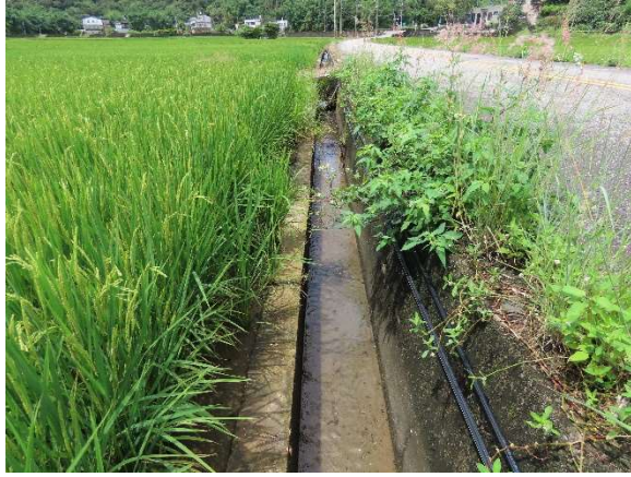
0K+560 東側灌溉溝渠
