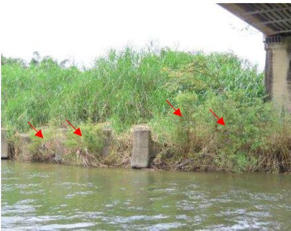
龍壽橋下方水柳 (TWD97 座標：224413，2714092)
