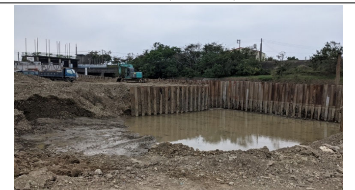
設置臨時擋土鋼板(110.04.16)
