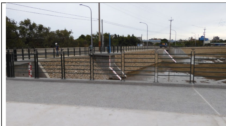
周邊人行道、護欄與道路已大致完成 (110.10.13)
