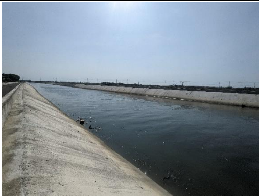
混凝土坡面工 (拍攝日期 110.9.9)
