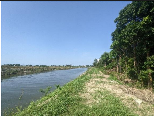
尚未整治土堤 (拍攝日期 110.9.9)
