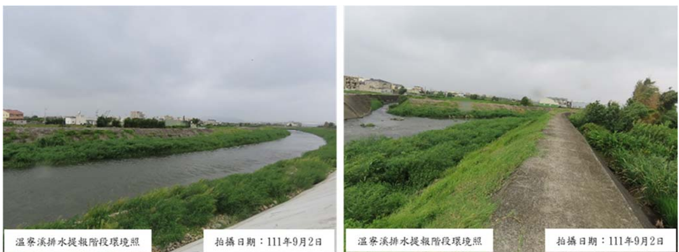
圖 1-1 大安區溫寮溪溫寮橋上游堤防改善應急工程環境照
