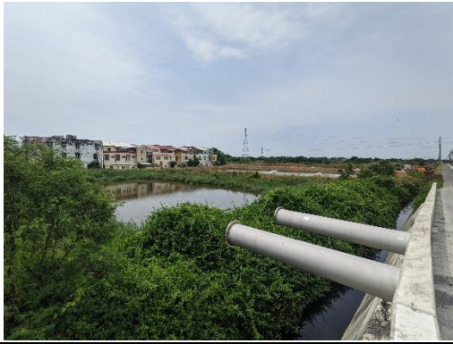
抽水站周邊魚塭及重力排水管 (拍攝時間 110.07.20)
