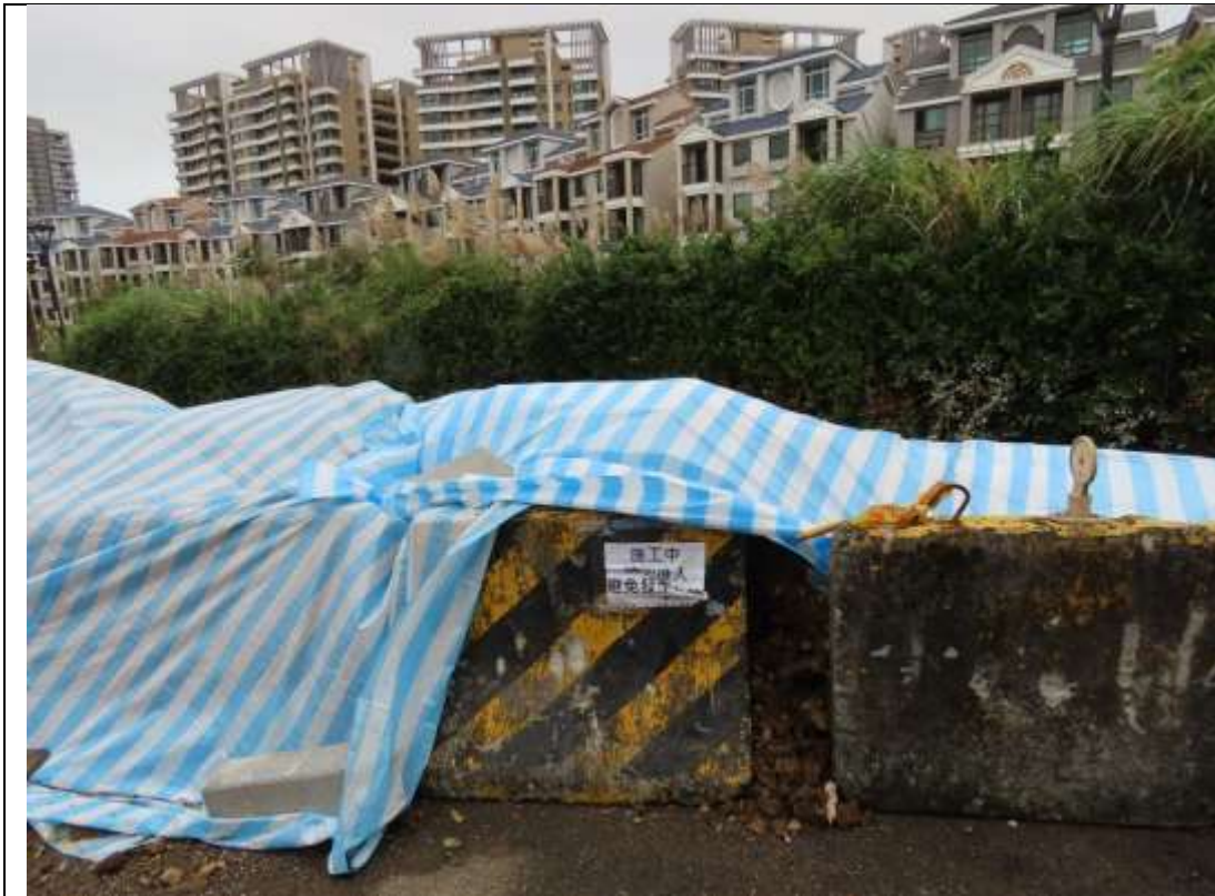
圖說：覆蓋防塵布，避免風吹造成揚塵。
