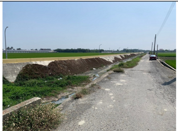
水岸及護坡照片
