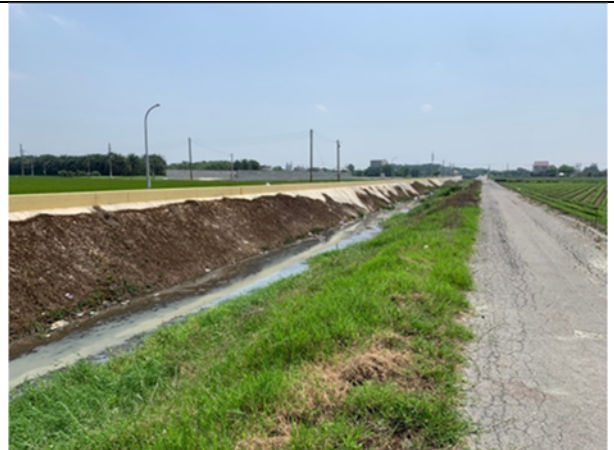
水岸及護坡照片
