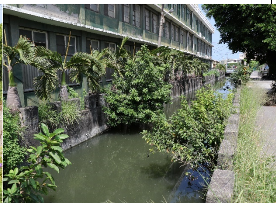
110/08/26 水岸及護坡照片(中游)
