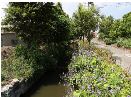
110/08/26 水岸及護坡照片(上游)
