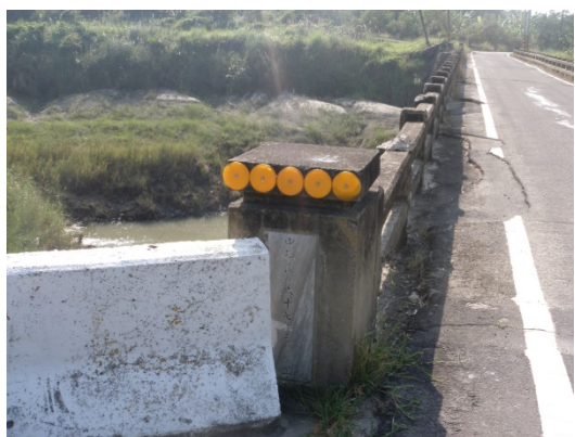
左鎮里的左鎮橋河床泥沙淤積，水流不暢，遇雨則淹橋面
