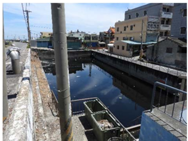
水岸及護坡照片
