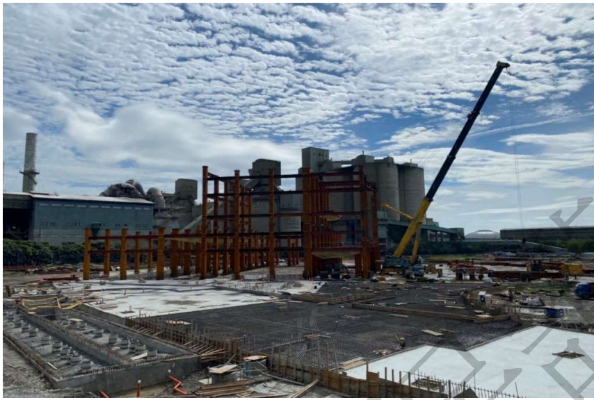
台泥公司和平廠 DAKA 再生資源利用中心興建現況
