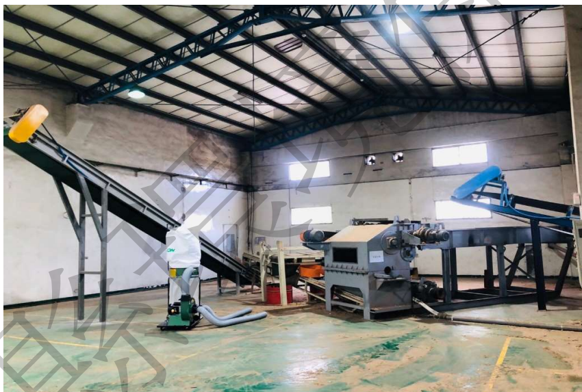
廢木材再利用廠房現況
