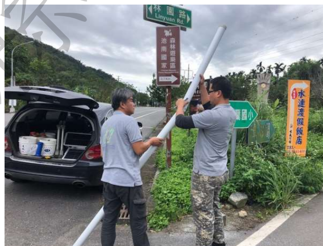
圖 5. 社區建置池南村太陽能路燈施工
