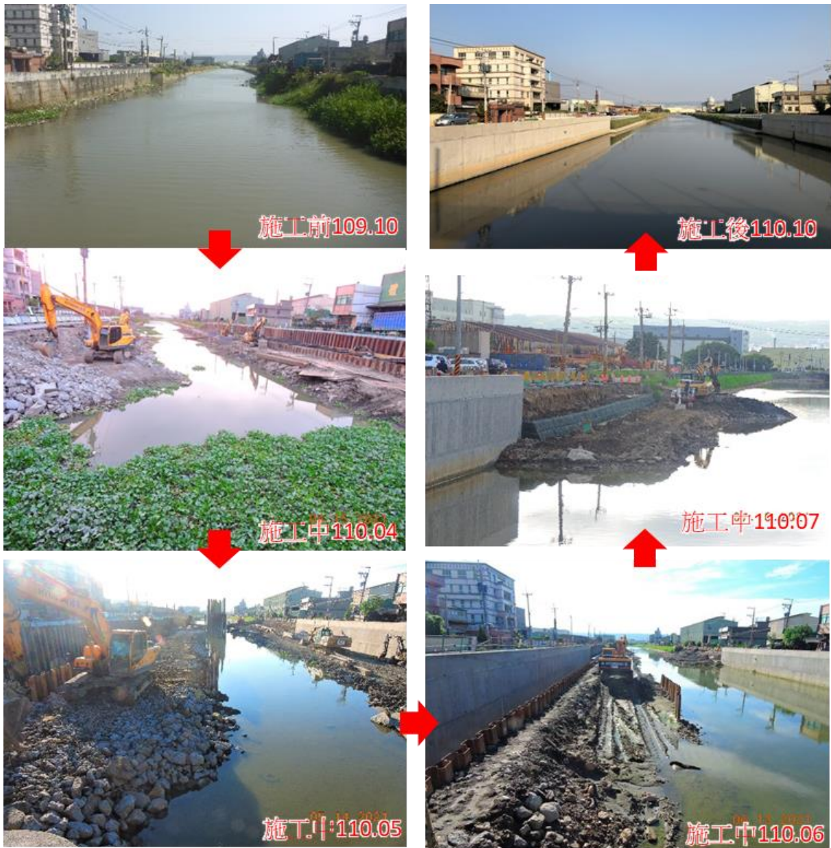
圖 3-5 施工前中後棲地變化
