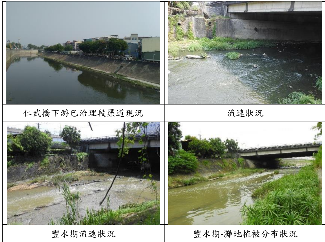
圖 4.9.1-3 「後勁溪排水仁武橋~高速公路橋瓶頸段治理工程」施工前工區環境照
