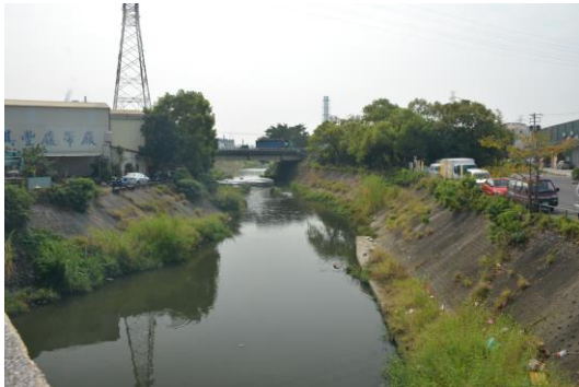
1.上游高速公路橋及預定工區渠道現況。
