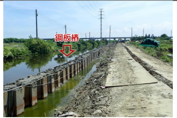
例圖 5、施工期間設置鋼板樁隔離水體，減少工程對水體干擾
