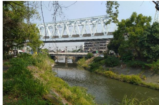
2.下游高鐵橋、仁武橋及預定工區渠道現況。
