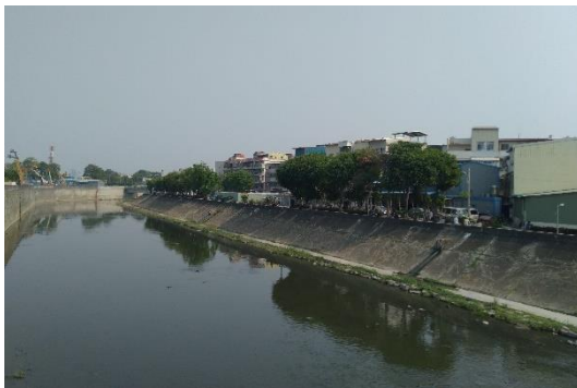
3.仁武橋下游已治理段渠道現況。
