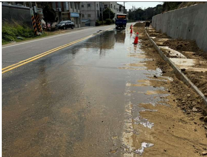
施工路面灑水避免土石飛揚
