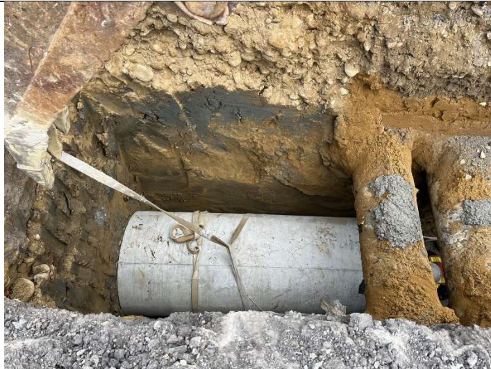
於 4K+424 埋設 RCP 管做為動物通道
