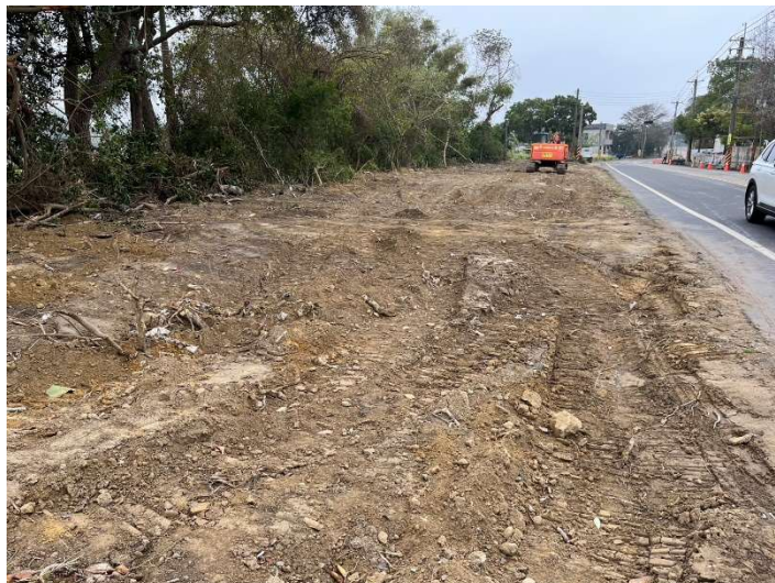
路樹移植後現況
