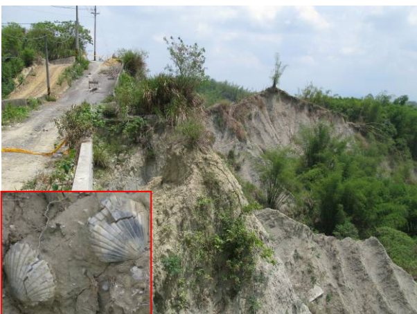
照片四~73 尖峰位於二重溪層與古亭坑泥岩層地層界限附近，陡崖稜線附近有許多扇貝化石。(柑子園農路旁)
