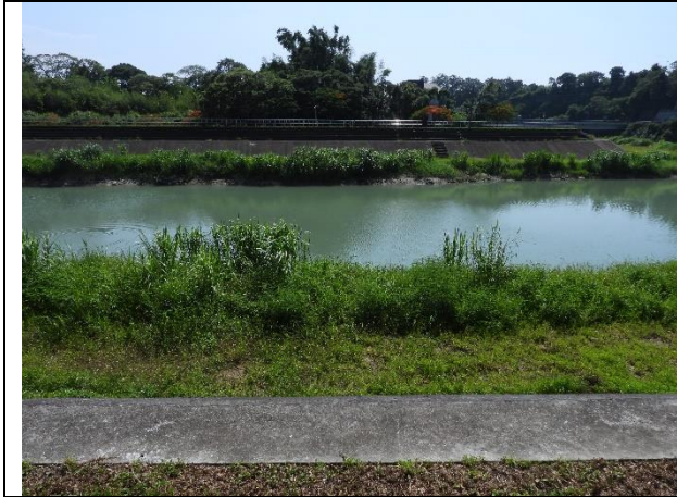
水岸及護坡照片
