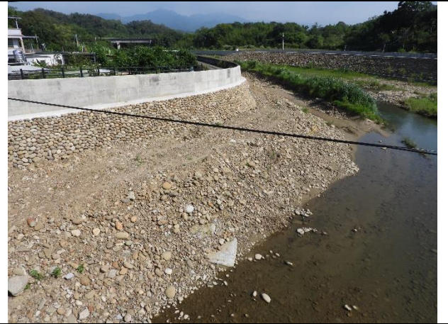
水岸及護坡照片
