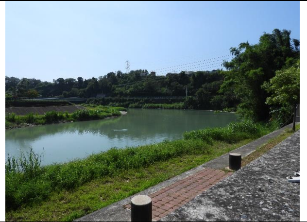
水岸及護坡照片
