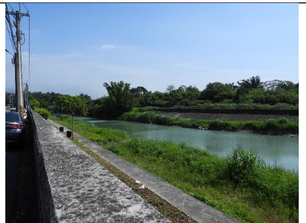
水岸及護坡照片
