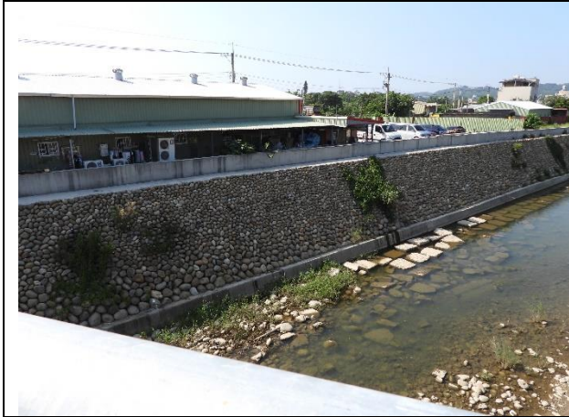
水岸及護坡照片
