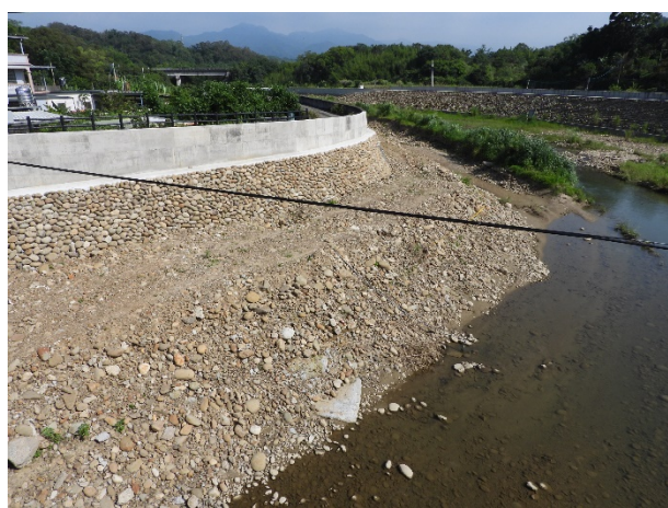
水岸及護坡照片
