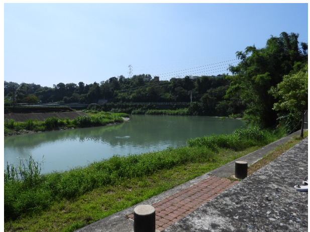
水岸及護坡照片
