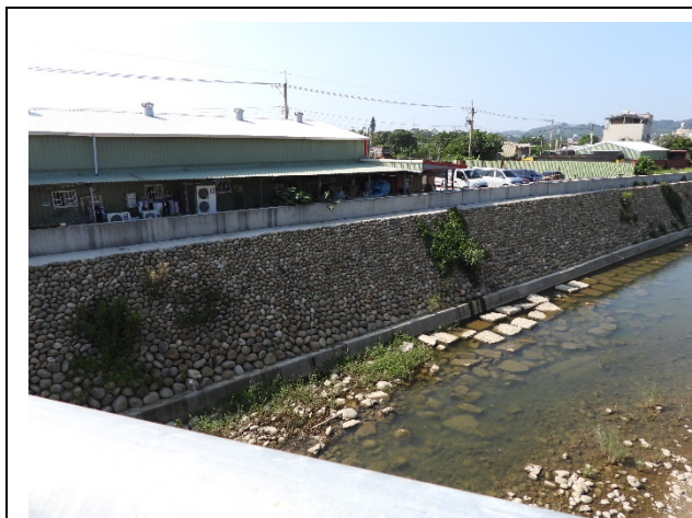
水岸及護坡照片
