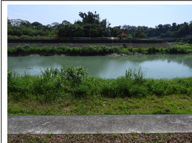
水岸及護坡照片
