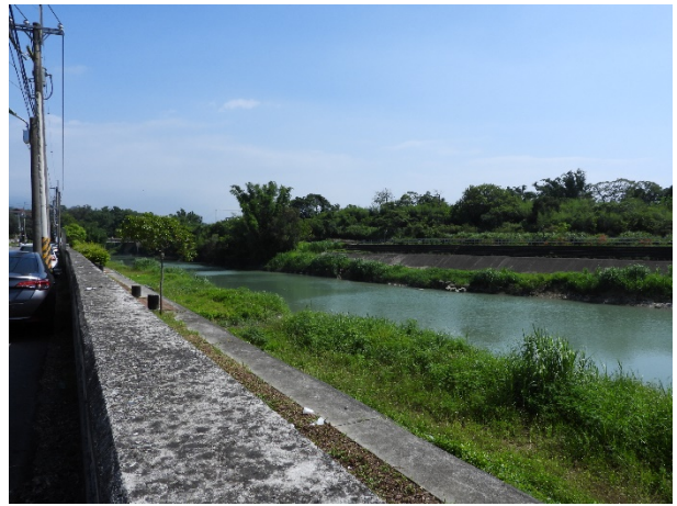
水岸及護坡照片
