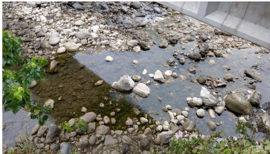
(龍安一號橋下)
