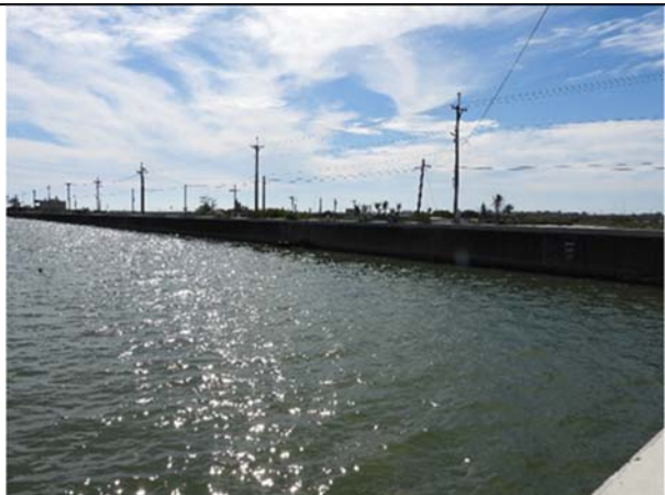
水岸及護坡照片
