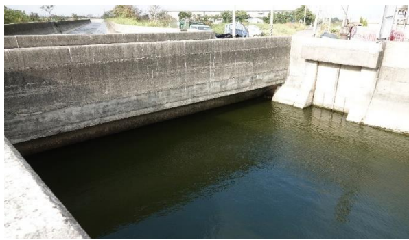
水岸及護坡照片-工區三
