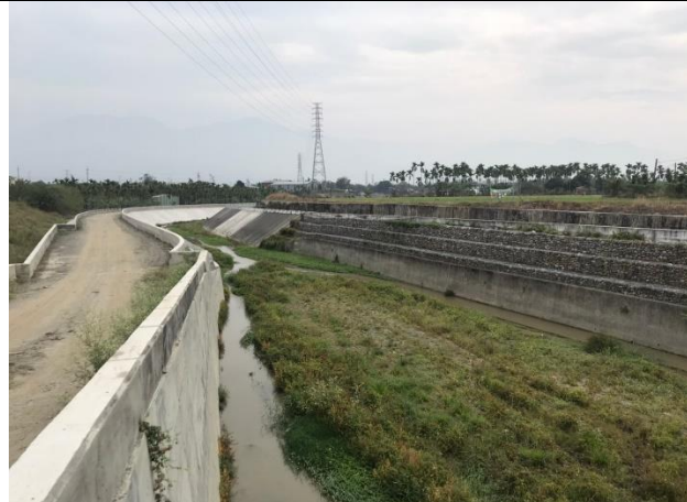
109 年 施工後照片
