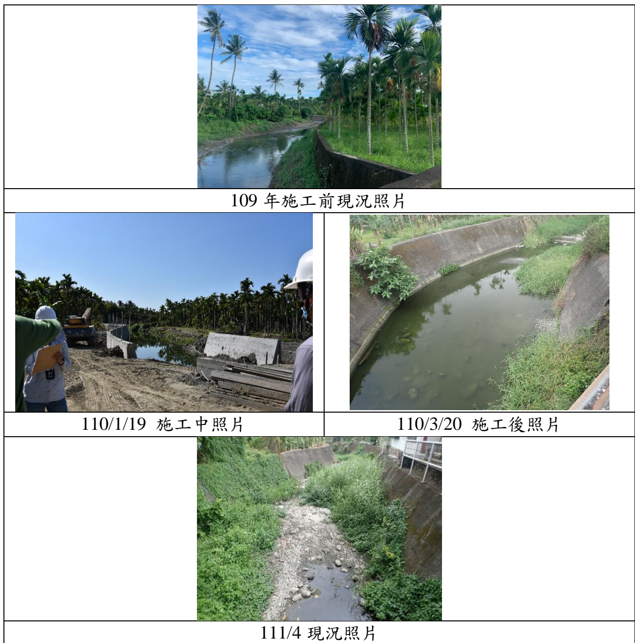
圖 3-171 萬巒鄉硫磺排水應急工程(二期)環境現況照片
