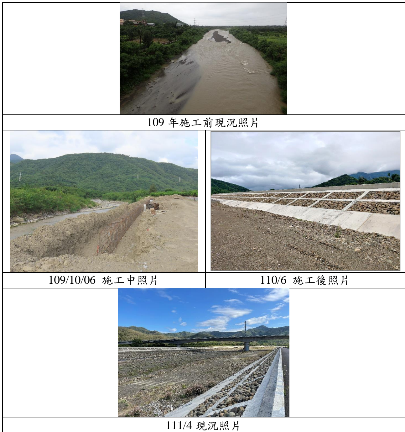
圖 3-169 楓港溪堤防改善工程(2K+050~2K+709)環境現況照片
