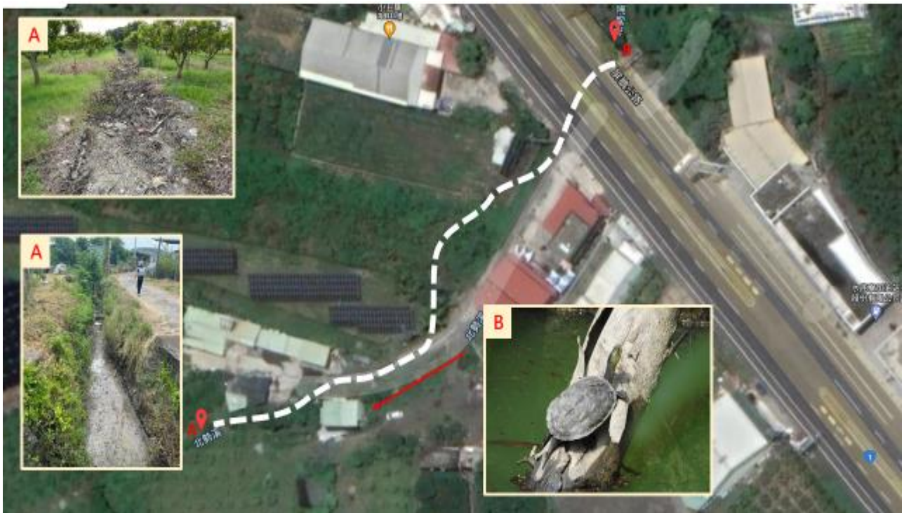
圖 3-12 台一線 437K+700 處易淹水區排水改善工程環境現況圖
