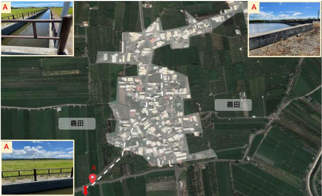
圖 3-27 萬華滯洪池周邊排水改善應急工程環境現況圖
