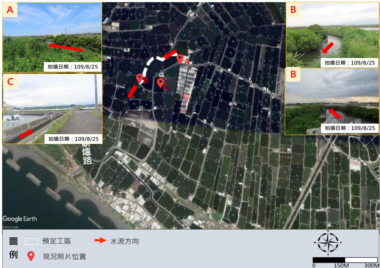
圖 3-50 枋寮鄉佳冬 12 號排水支線應急工程環境現況圖
