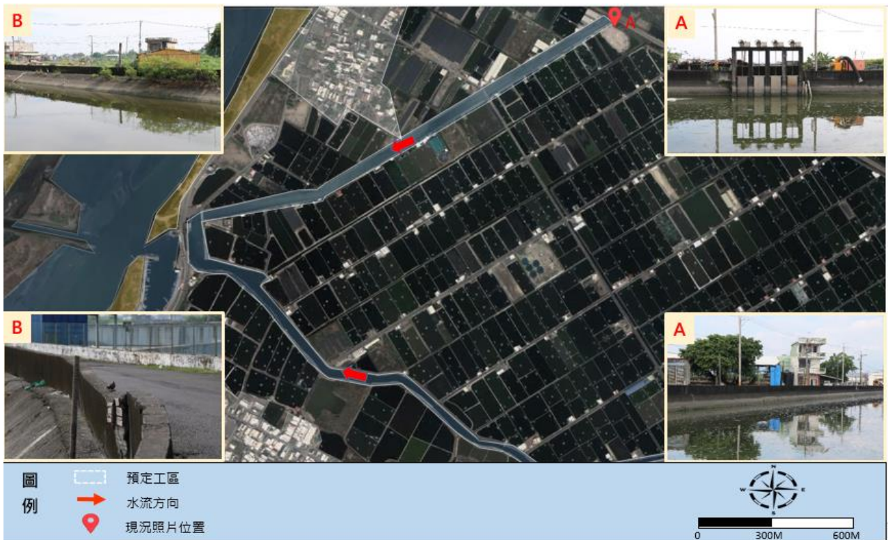
圖 3-47 塭子一號及二號排水護岸加高改善應急工程環境現況圖
