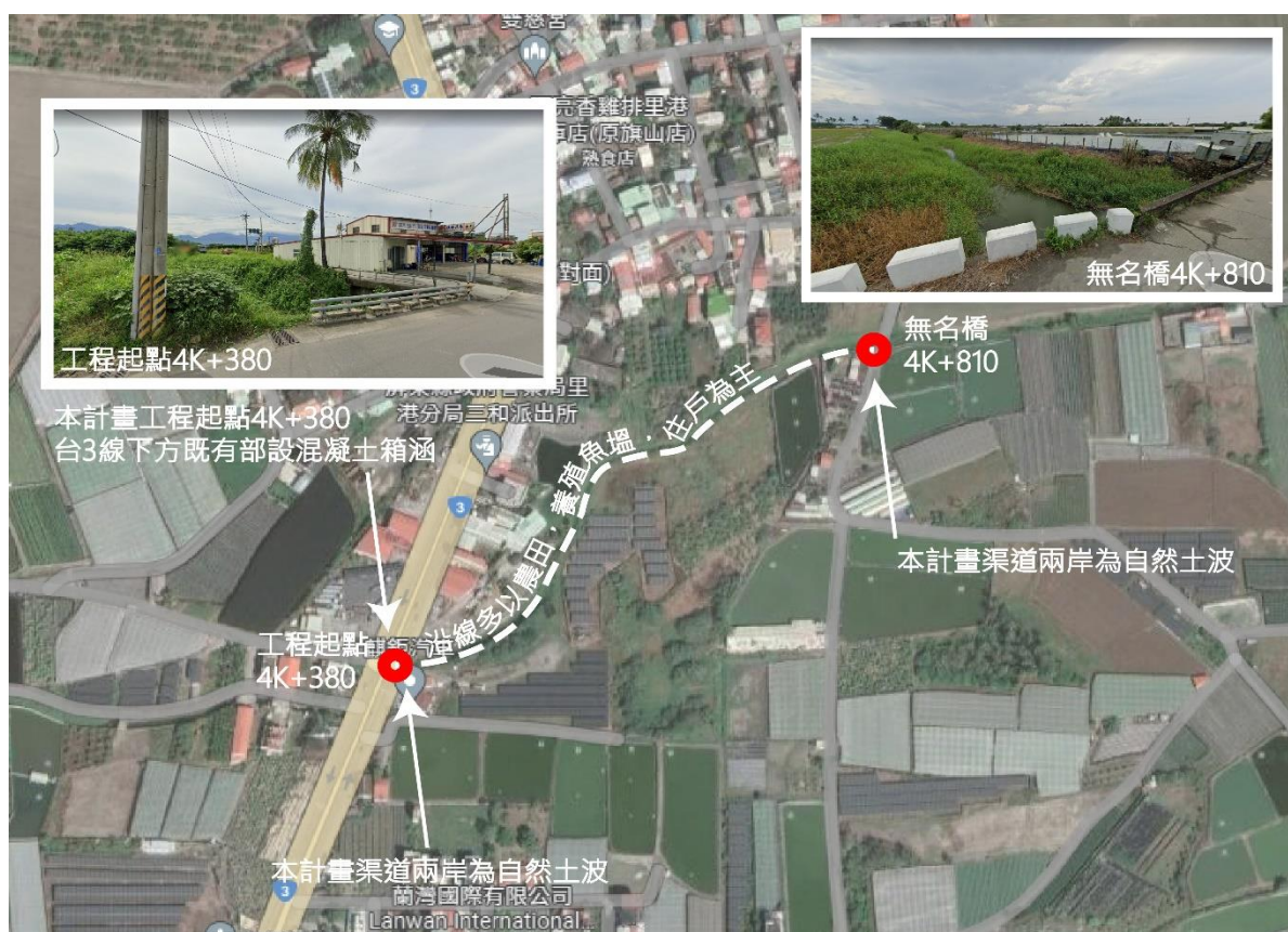
圖 3-116 土庫排水改善工程委託測量設計技術服務案工程環境現況圖
