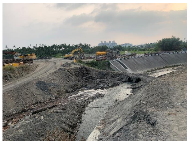
109 年 施工中照片
