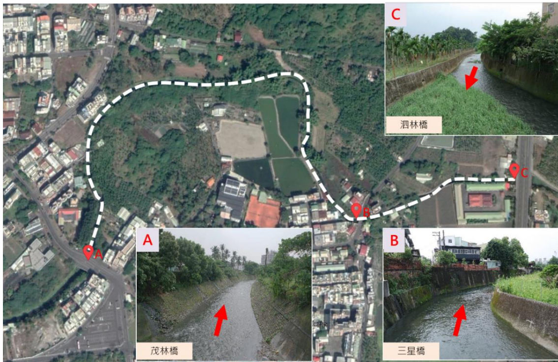
圖 3-23 民治溪排水改善工程(茂林橋(4k+252)~泗林橋(第一期)環境現況圖
