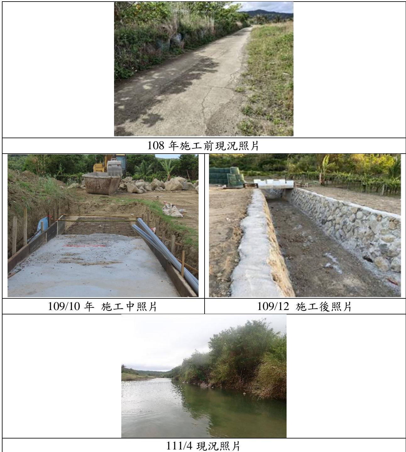
圖 3-167 牛埔溪排水護岸改善工程環境現況照片
