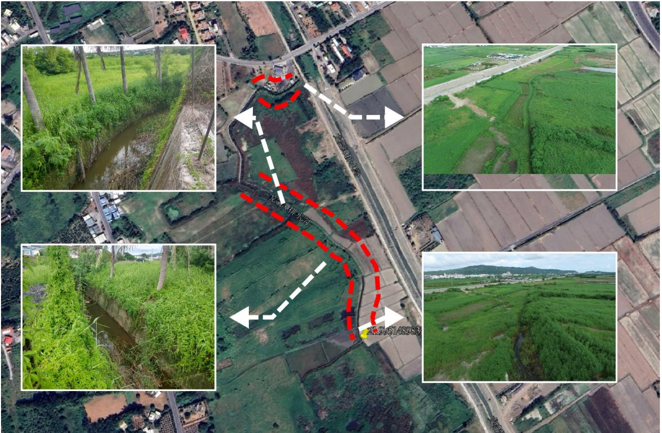
圖 3-83 恆春鎮東門溪旁德和段應急二期工程環境現況圖
