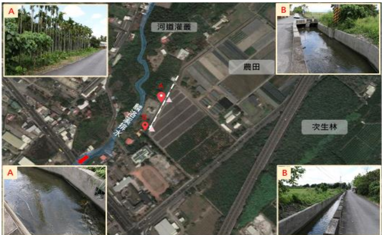
圖 3-35 麟洛鄉麟洛排水支流應急工程環境現況圖
