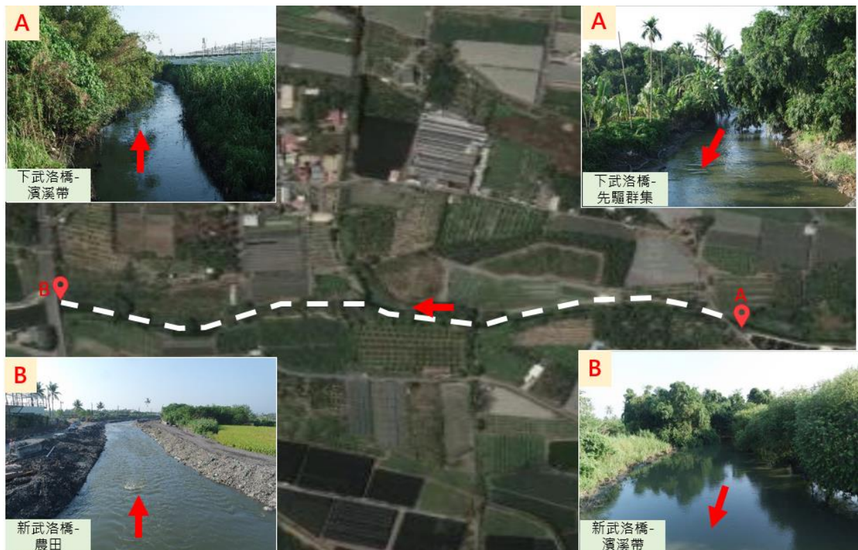
圖 3-140 武洛溪排水整治工程(新武洛橋~下武洛橋)含橋梁改建工程環境現況圖
