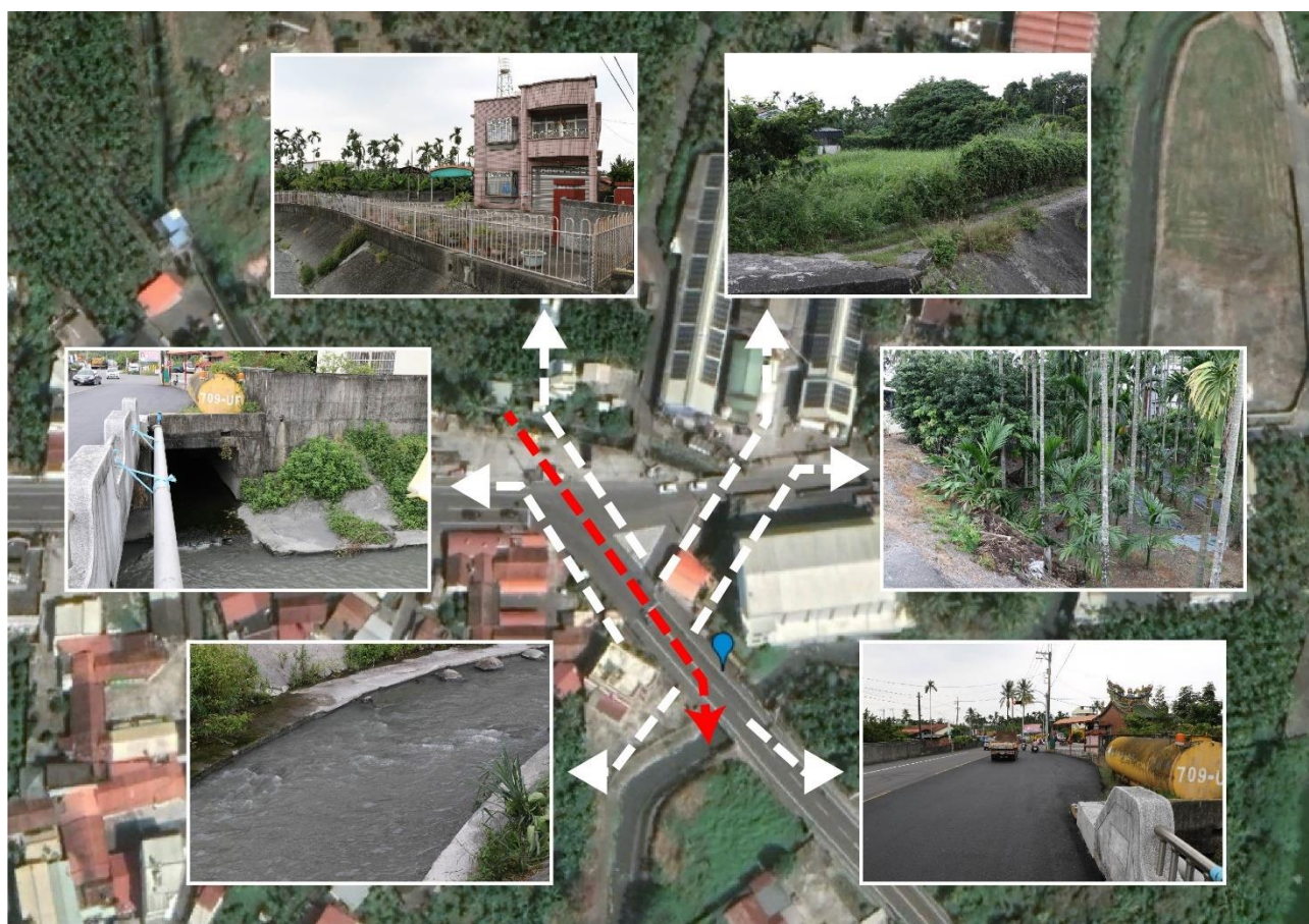
圖 3-77 大湖排水長麟橋處新設疏洪箱涵應急工程環境現況圖
