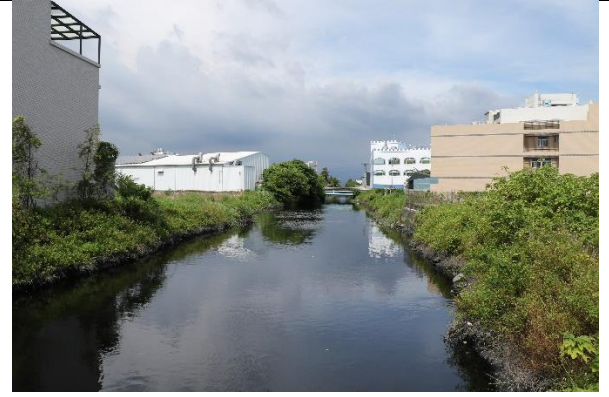
右岸施工工區
