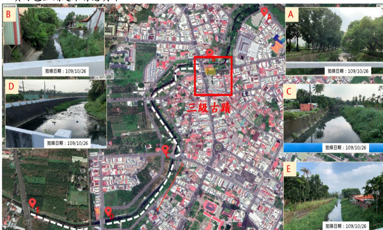
圖 30 龍頸溪排水改善工程(8K+495-8K+735)(含橋梁改建)環境現況圖
