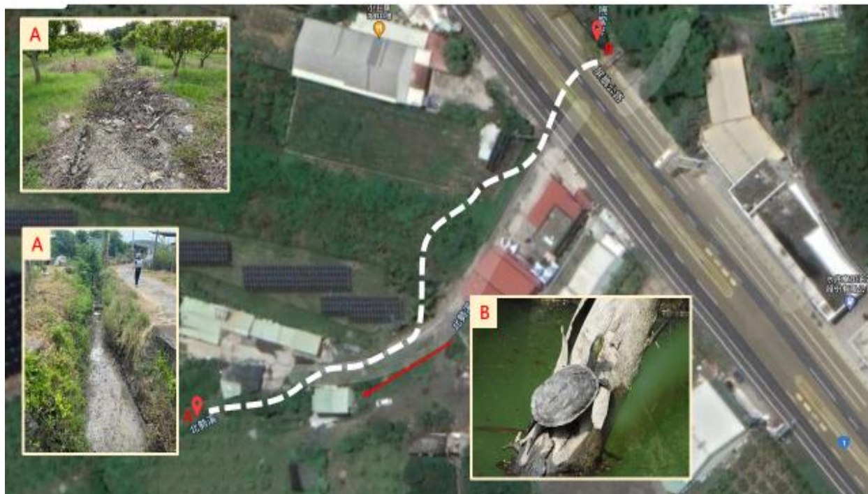
圖 2 台一線 437K+700 處易淹水區排水改善工程環境現況圖
