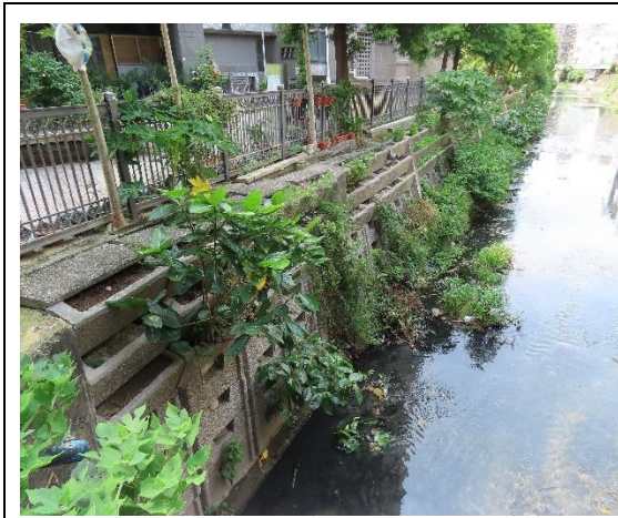
水岸及護坡照片
