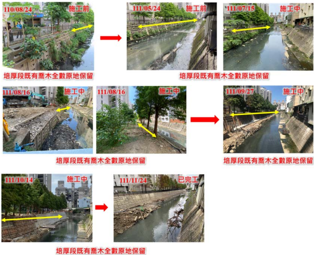
(b) 施工前、中、後護岸培厚段之喬木原地保留與工程施做情況
