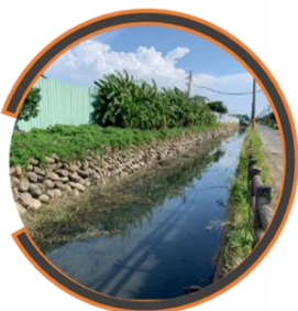
港北金城橋排水幹線護岸新建工程(0K+302-0K+966)
