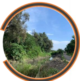
港北金城橋排水幹線護岸新建應急工程(0K+090-0K+302)
