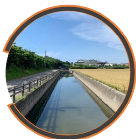
港北金城橋排水幹線護岸新建工程(1K+000-1K+526)
