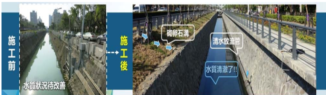
圖 7 民生大排改善及水環境營造計畫施工前後對照圖
