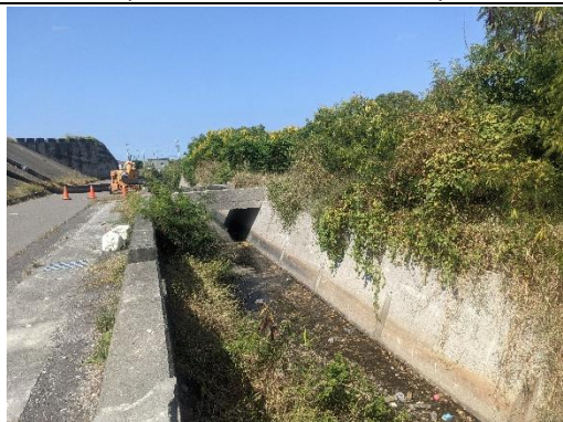
水池與既有抽水站的連接水溝 (拍攝時間 110.10.19)
