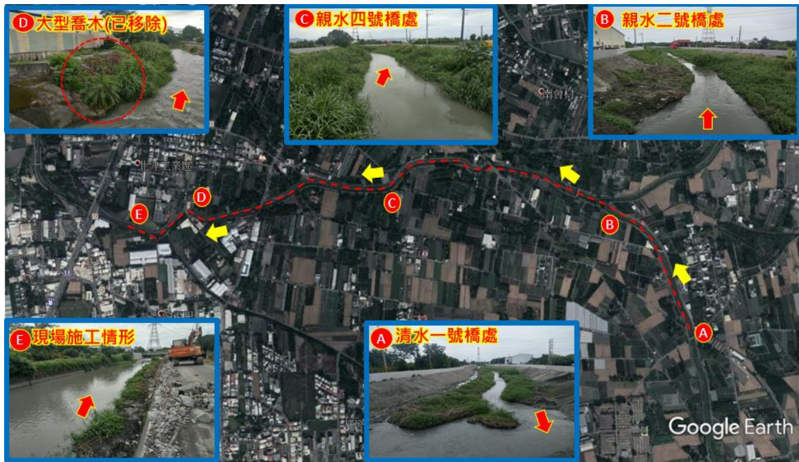
圖 1 清水溪排水治理及橋梁改建工程併辦土石標售環境現況圖
