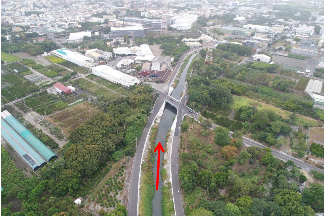
圖 7 清水溪排水治理及橋梁改建工程之棲地環境空拍圖(中游)(109/10/21)
