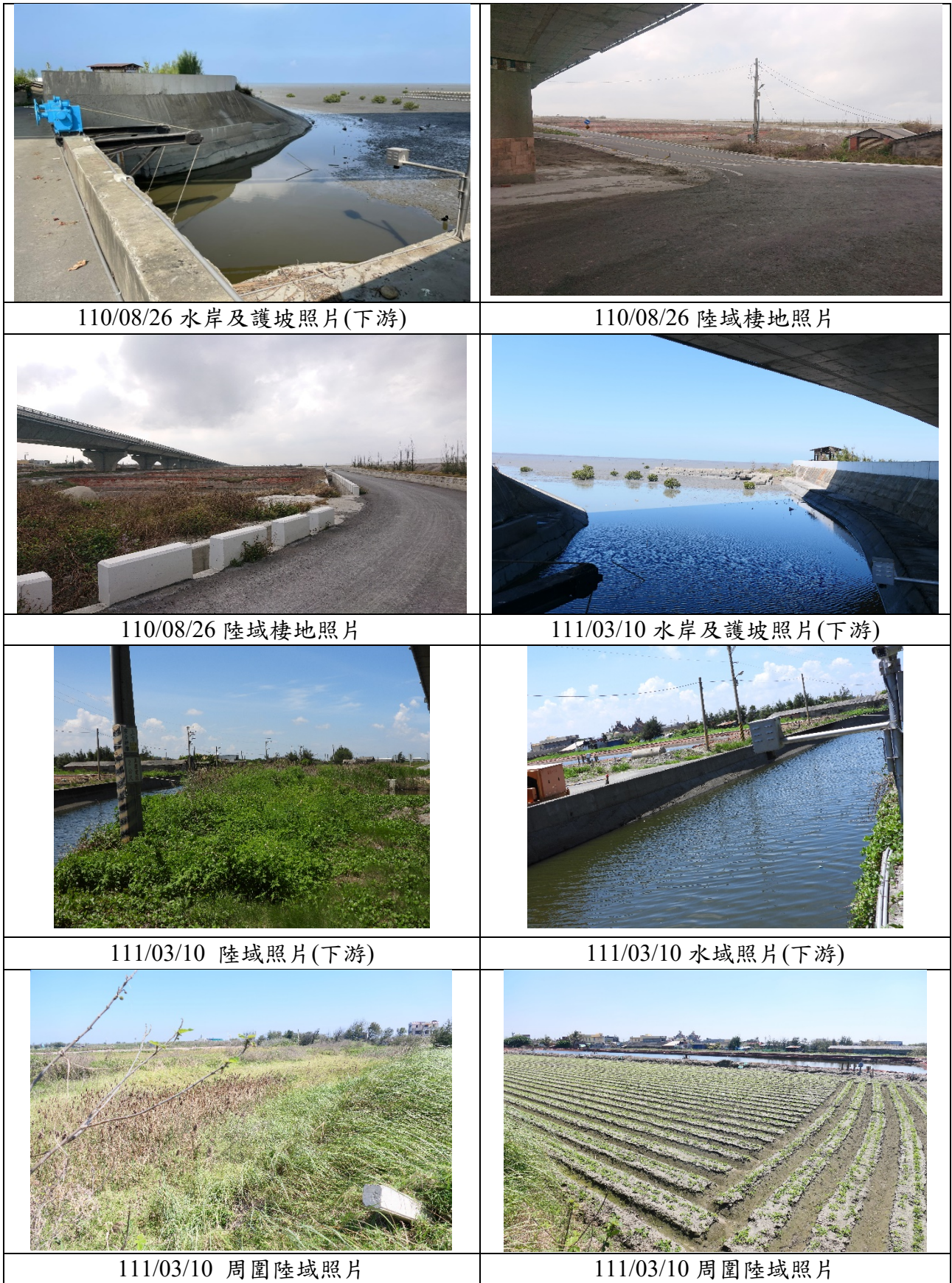
圖 74 新街排水增設閘門式抽水機工程環境現況照片(施工階段)
