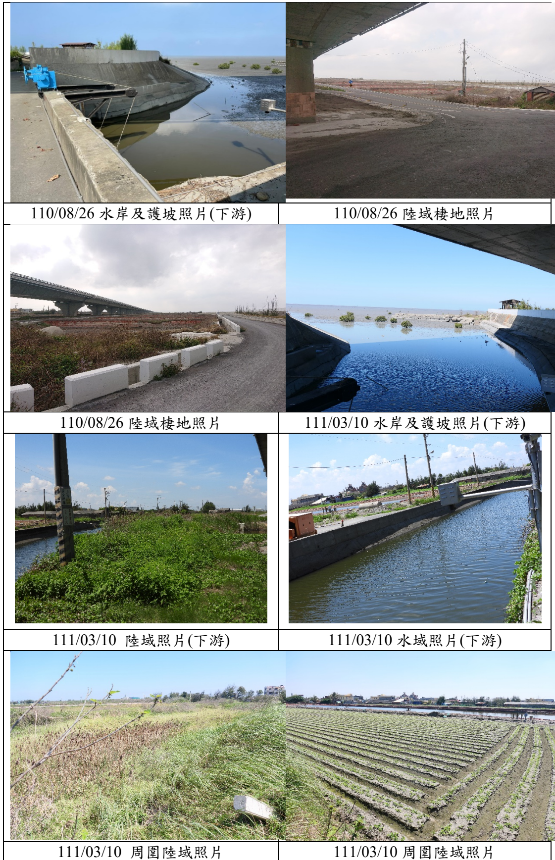
圖 18 新街排水增設閘門式抽水機工程增設閘門式抽水機工程環境現況照片(規劃設計階段)
