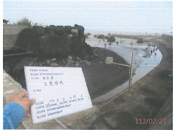
說明：工區內生態檢核（抽水井）
