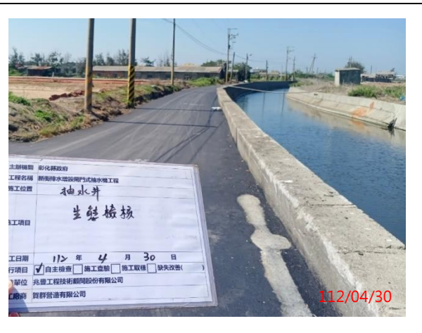
說明：工區內生態檢核（抽水井）
