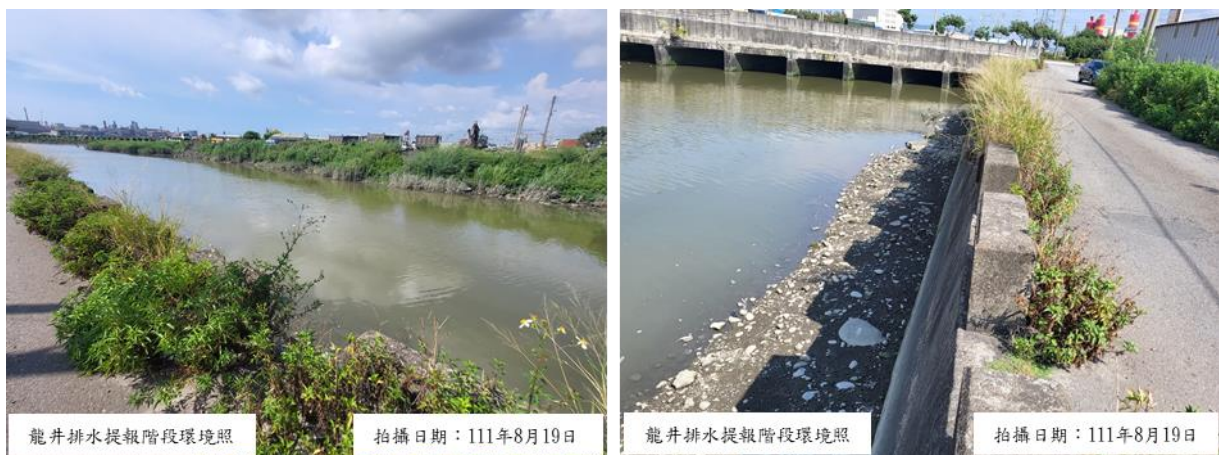
圖 1-1 龍井區龍井排水臨港路下游左岸護岸改善應急工程環境照
