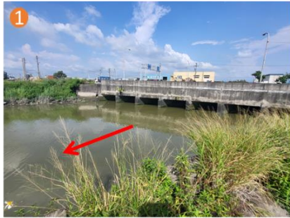
龍井區龍井排水臨港路下游左岸護岸改善應急工程
