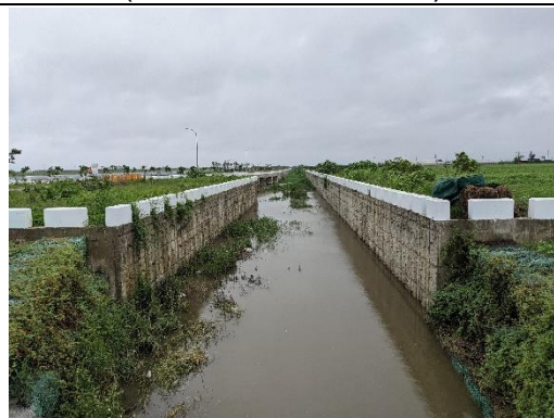
部分區段兩側已設置混凝土堤岸 (拍攝日期 110.06.23)
