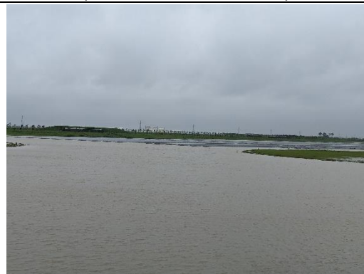
新庄農場滯洪池及其上架設之光電板 (拍攝日期 110.06.23)
