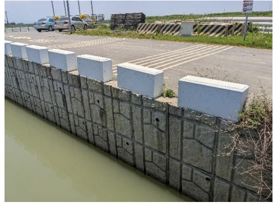
工區現況照 (拍攝日期 111.07.25)
