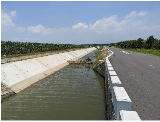
工區現況照 (拍攝日期 111.07.25)
