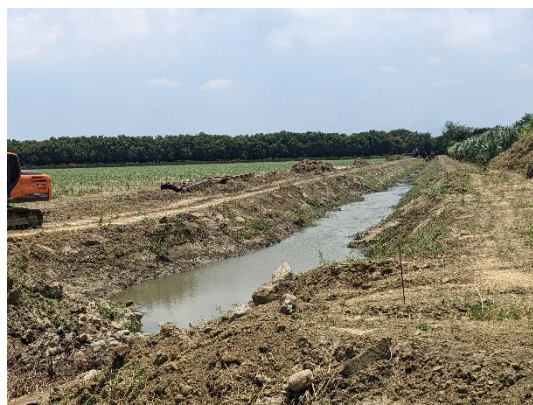
工區現況照 (拍攝日期 111.07.25)
