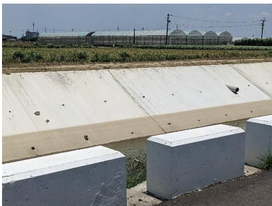
工區現況照 (拍攝日期 111.07.25)
