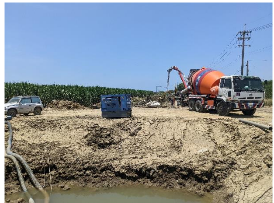
工區現況照 (拍攝日期 111.07.25)
