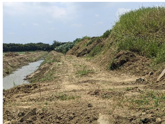
工區現況照 (拍攝日期 111.07.25)
