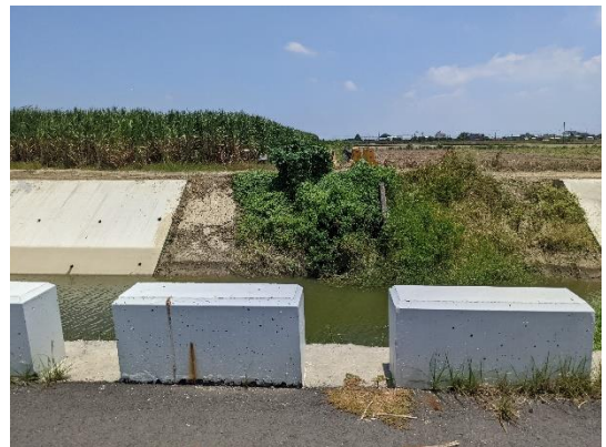
工區現況照 (拍攝日期 111.07.25)
