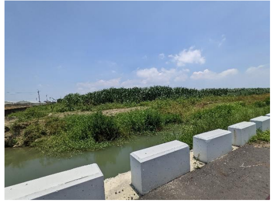
工區現況照 (拍攝日期 111.07.25)
