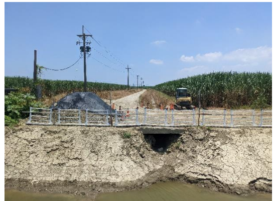
工區現況照 (拍攝日期 111.07.25)
