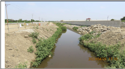
施工起點配合疏洪箱涵工程協調介面銜接尚約有 56m 未施作
