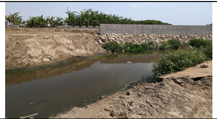
施工終點與上游段工程銜接處水域未受阻
