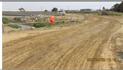
施工便道經常灑水抑制揚塵
